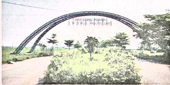
Dự án Đầu tư xây dựng và kinh doanh hạ tầng KCN vừa và nhỏ Nhân Hòa (phường Phương Liễu, thị xã Quế Võ, Bắc Ninh). Ảnh: Vân Trường
