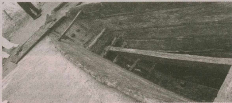
Kết cấu đầu thuyền với “ghế tựa” gắn vào phần đầu thuyền độc mộc, đáy kéo dài làm chỗ tựa đón các ván nâng mạn thuyền ở đầu hẹp thuyền. Thanh ngang giữa thuyền nối gia cố phần đầu thuyền với các thanh ngang lòng thuyền
