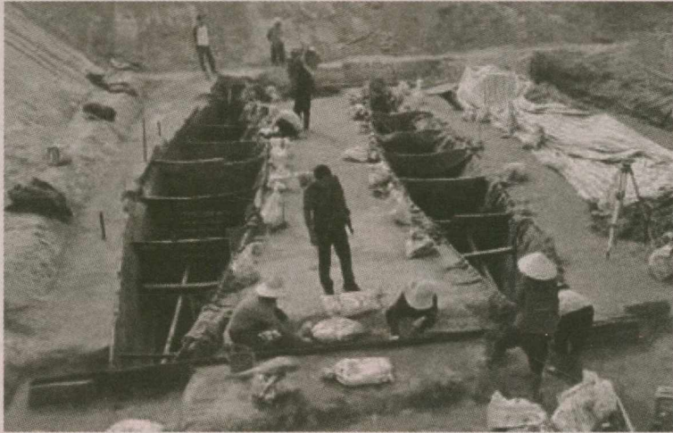
Chi tiết đầu thuyền (bên phải) ngoài chắc thanh giăng ngang, mặt cắt hình thước thợ (L) nối với thuyền kia. Khắc lôm trên hai mạn phía bên phải hình chụp là bằng chứng của một thanh giăng ngang khác, cùng bề mặt hai mạn thuyền tạo thành mặt phẳng
