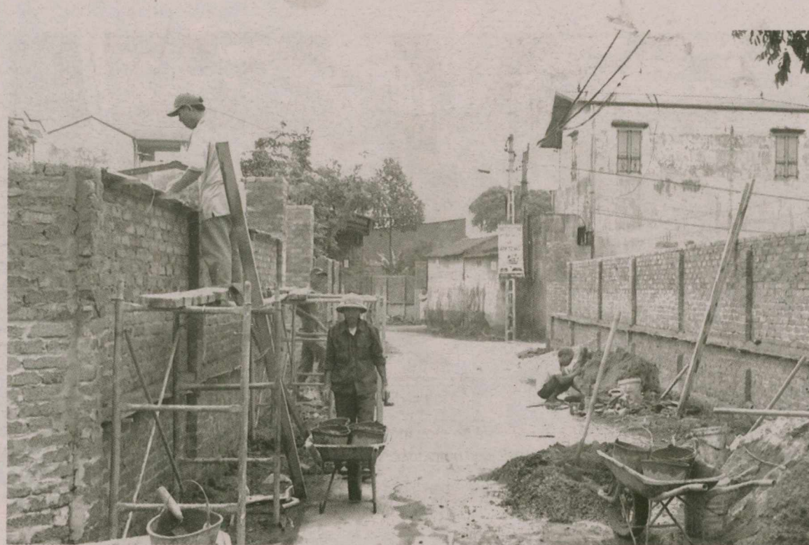
Người dân thôn Cầu Đào, xã Nhân Thắng tự nguyện dịch tường rào, hiến đất để mở rộng đường giao thông
