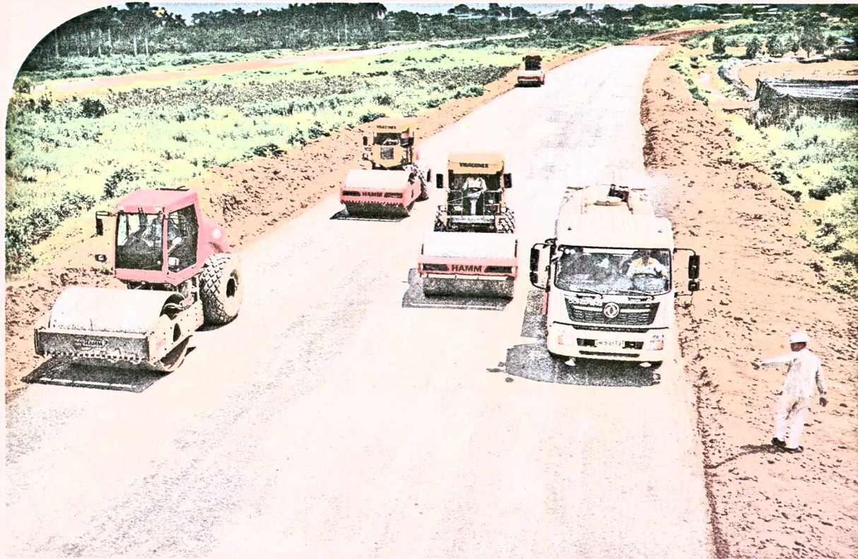
Nhà thầu huy động máy móc thi công đường Vành đai 4 đoạn qua huyện Hoài Đức (Hà Nội)
