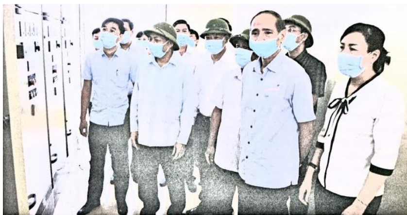
Bí thư Tỉnh ủy Nguyễn Nhân Chiến kiểm tra tại trạm bơm Vạn Ninh (Gia Bình).
