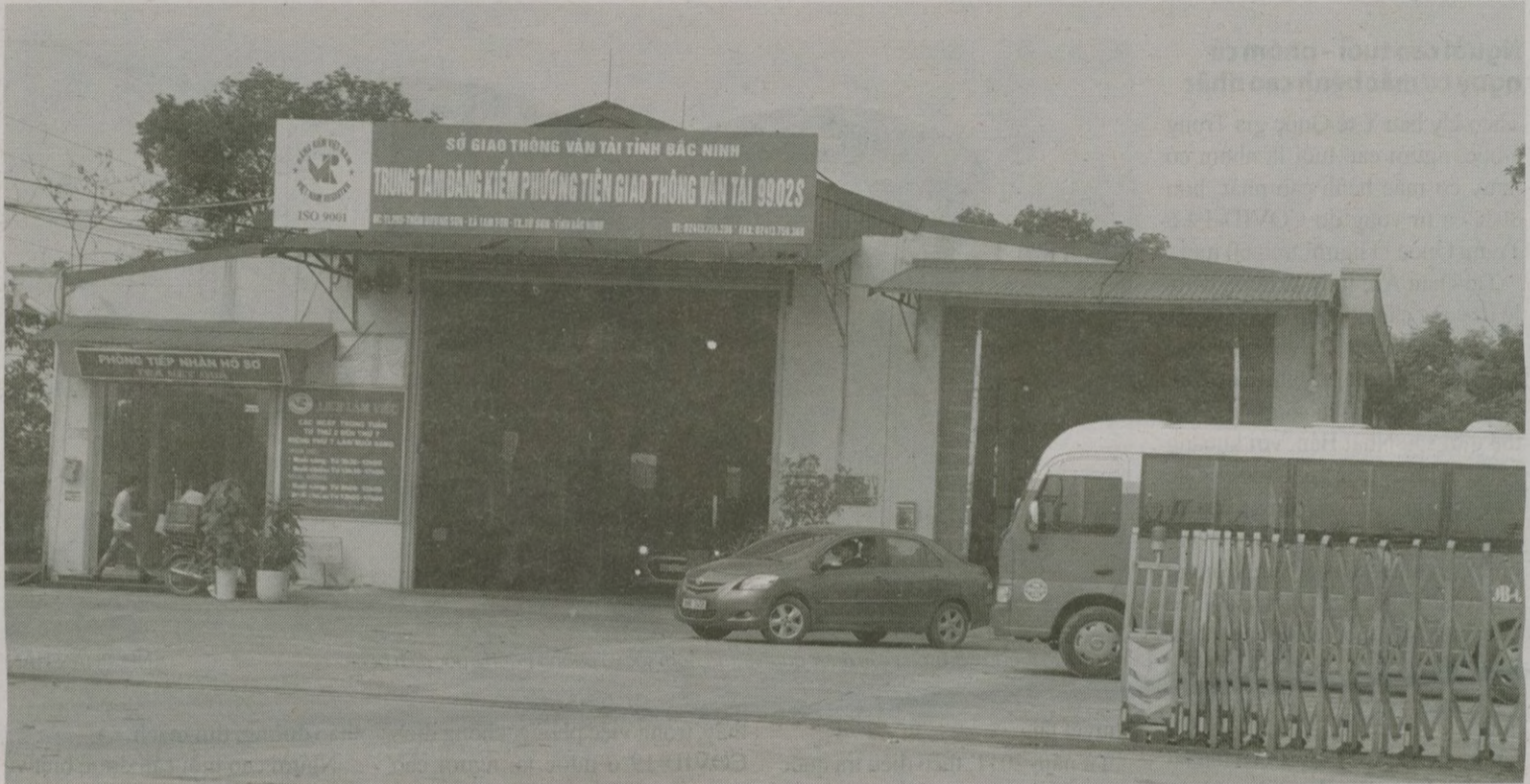
Trung tâm đăng kiểm phương tiện giao thông vận tải 9902S ở Từ Sơn, Bắc Ninh.
