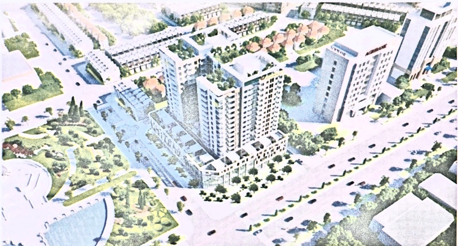
Thanh tra dự án đầu tư, xây dựng tổ hợp trung tâm thương mại, dịch vụ và căn hộ cao cấp để bán tại phường Ninh Xá, TP Bắc Ninh, Thanh tra tỉnh Bắc Ninh đã thu hồi số tiền hơn 3,8 tỷ đồng. Ảnh: Internet
